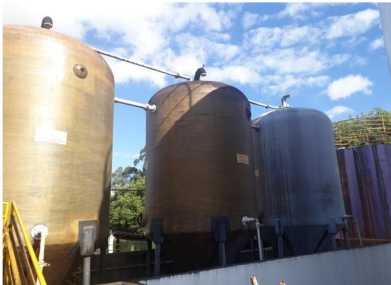
**Figura 24.** Tonéis de decantação primária.
